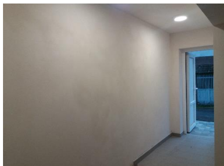
Obr. 8 - Obec Leštinka-Oprava hasičské zbrojnice v budově OU Leštinka
