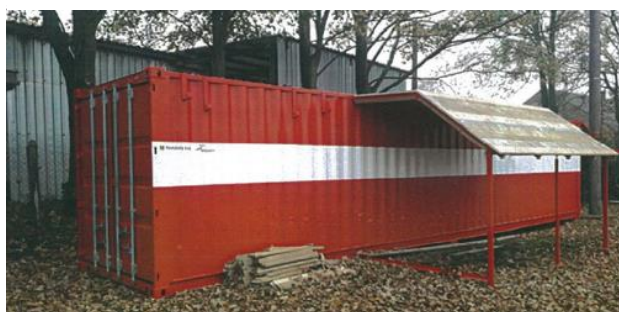
Obr. 9 - ČMS-SDH Štěpánov- Oprava mobilního hasičského skladu
