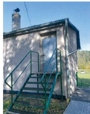
Obr. 3 - Obec Vrbatův Kostelec – Oprava sportovních kabin
