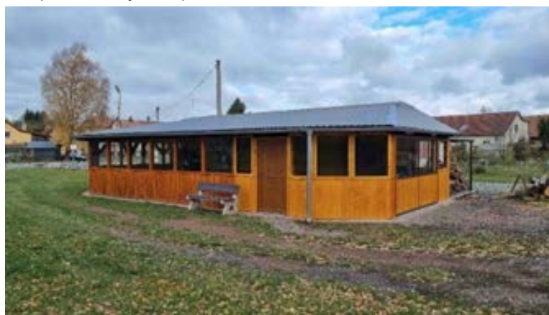
Obec Zaječice, rekonstrukce spolkového domu v obci Zaječice včetně venkovní pergoly
