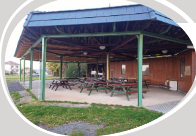
SH ČMS – Sbor dobrovolných hasičů Chacholice – Zastřešení venkovního parketu v Chacholicích – II. etapa
