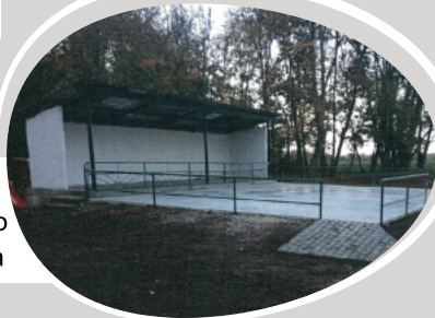
Obec Přestavky – Revitalizace kulturního prostoru – první etapa
