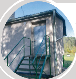
Obec Vrbatův Kostelec – Oprava sportovních kabin Vrbatův Kostelec
