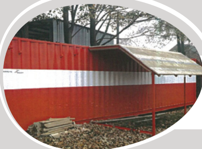
SH ČMS – SDH Štěpánov – Oprava mobilního hasičského skladu
